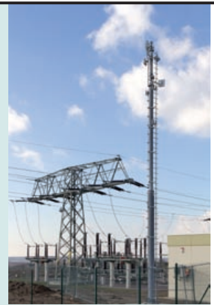
Die Anbindung an den Glasfaser-Backbone der Enviatel an Übergabepunkten wie Umspannwerken erfolgt per Richtfunk im meldepflichtigen BFWA-Band (Broadband-Fixed-Wireless-Access) im Frequenzbereich 5,755 GHz bis 5,875 GHz.
